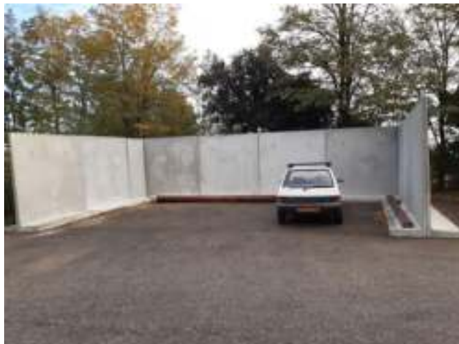
Illustration 28 : Exemple de casier de dépôt de déchets (source : CEREG)
